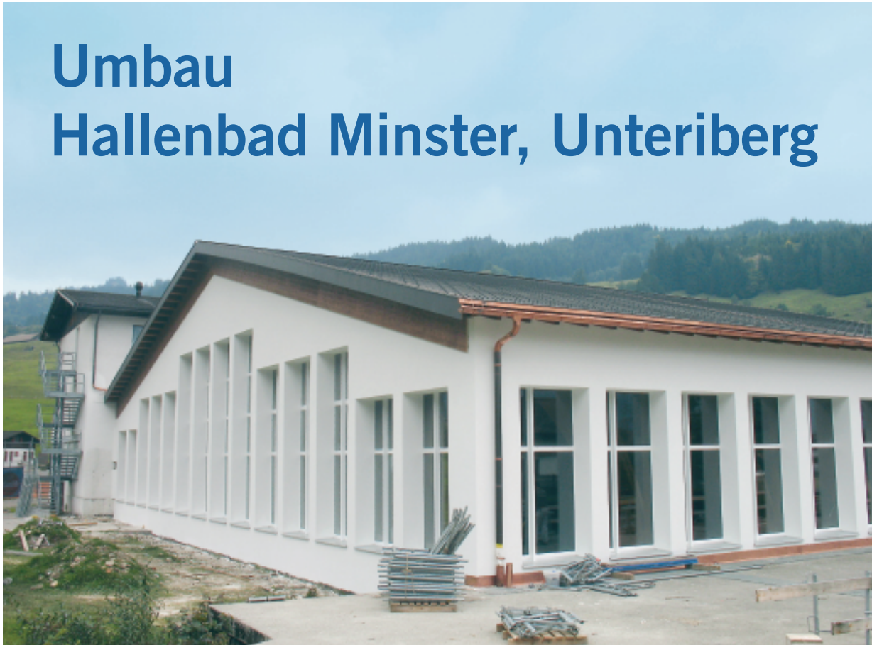
Die Fensterfront, Aussenwände und das Dach des Hallenbads entsprechen dem Minergie-Standard.
