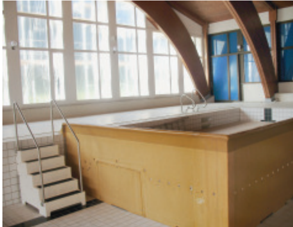
Die neue Treppe im Schwimmbecken erleichtert den Ein- und Ausstieg.
