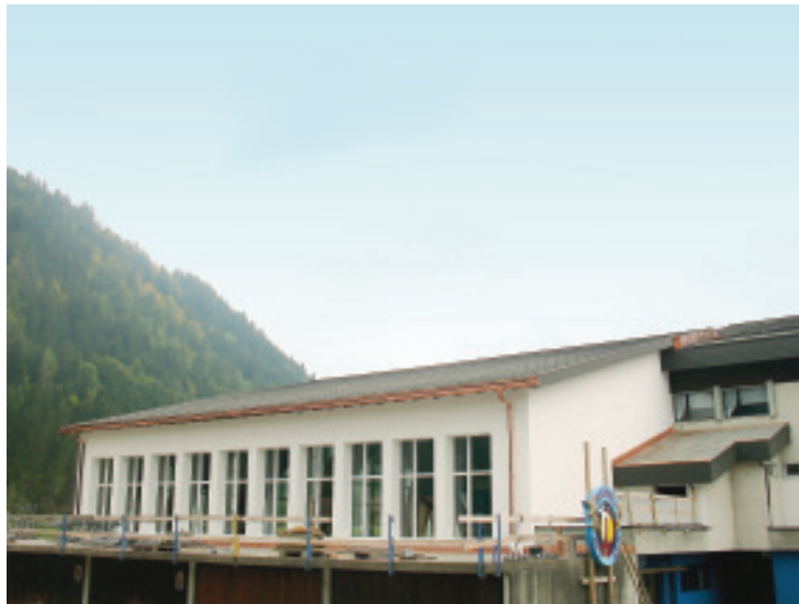
Die Aussenwände wurden zusätzlich mit einer 200 mm starken verputzten Wärmedämmung ergänzt.
